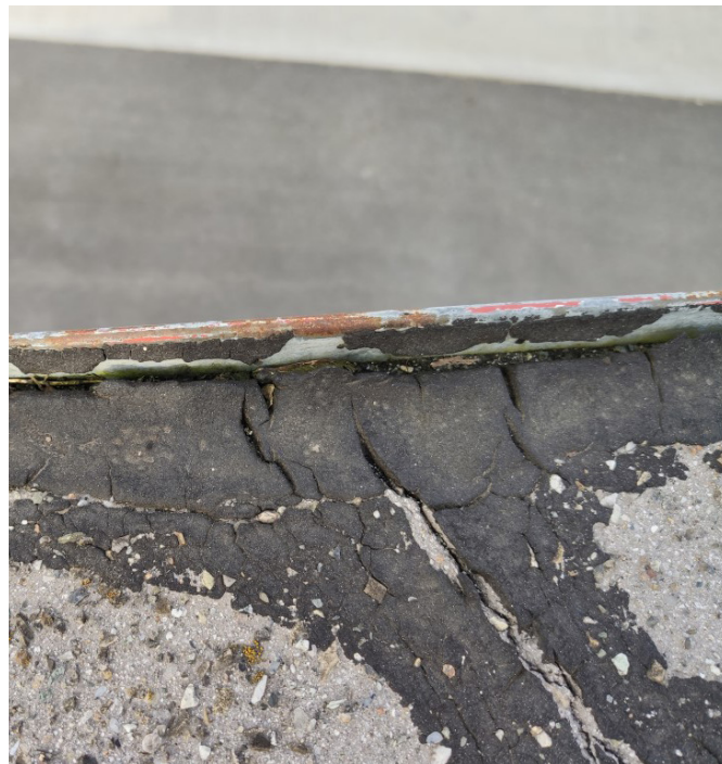
Undichter Flachdachabschluss
