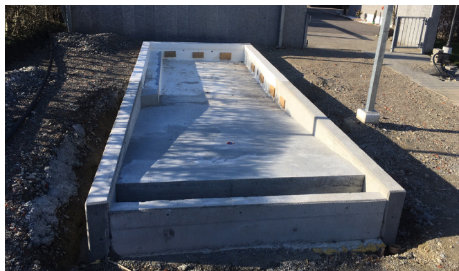
Das neue Kinderbecken ist in Arbeit
