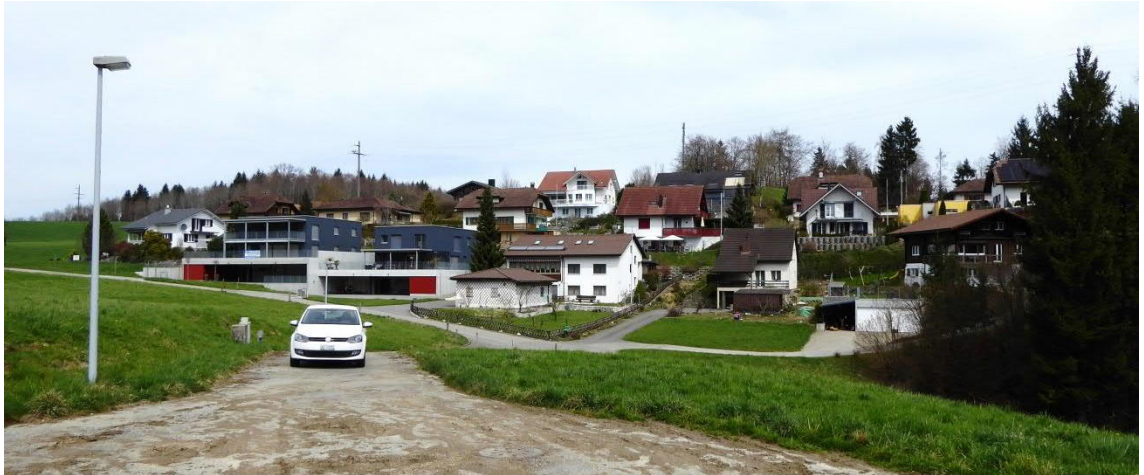
Abbildung 8 Strasse Kehrmatt von Süden gesehen, im Hintergrund das Wohnquartier Kehrack.
